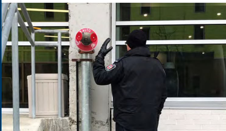
Vérification de l'installation et de l'accessibilité d'un raccord pompier.
