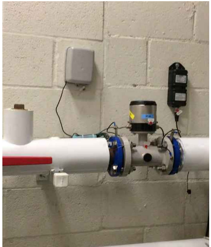
Compteur magnétique avec un émetteur et une batterie dans un immeuble commercial
