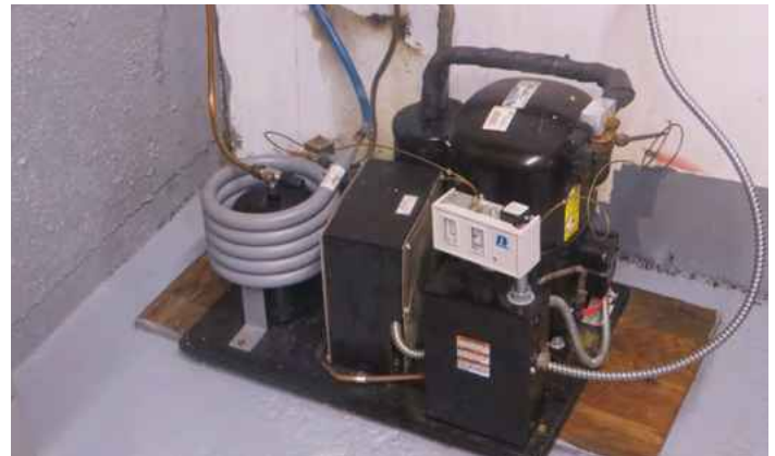
Exemple d'appareil de refroidissement utilisant de l'eau potable
