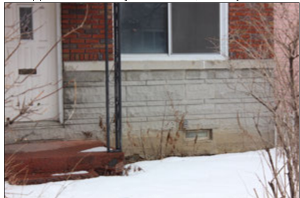
Vue rapprochée de la façade du 7469, rue Boyer. Détail du soupirail et du bas de la maison.
