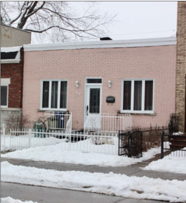
Vue de l'immeuble voisin, le 7463, rue Boyer.
