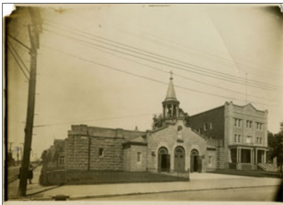
Presbytère et l'ancien soubassement de l'église Notre-Dame-du-Rosaire de Villeray, rue Saint-Hubert, coin rue Villeray. Photographie prise avant 1930. Source : Collection Félix Barrière, BAnQ, cote : P748,S1,P1393.
