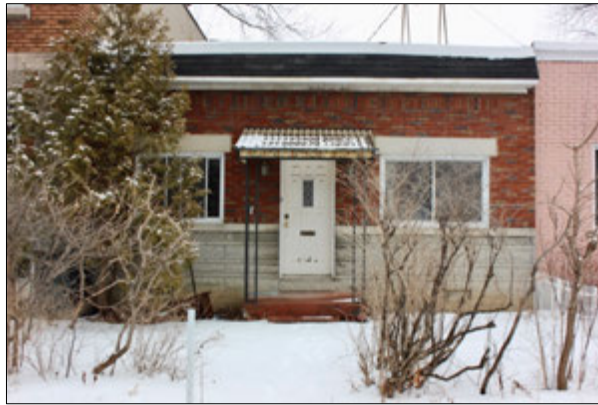
Vue de l'immeuble 7469, rue Boyer. Source : Conrad Gallant, 2021.
