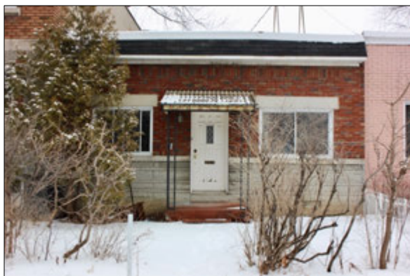
Photographie de l'édifice [7469, rue Boyer] — Vue de la façade sur la rue Bellechasse.
