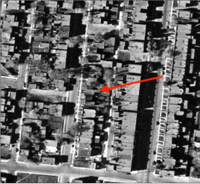
Agrandissement de la photographie précédente. Vue aérienne de notre secteur en 1947, avec notre immeuble indiqué par une flèche. Source : Archives de la Ville de Montréal, cote : VM97-3, 07, P16-35
