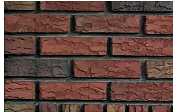
MAÇONNERIE EXISTANTE CONSERVÉE
