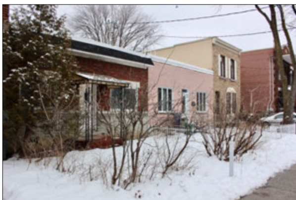
Photographie de l'édifice et de son contexte [7469, rue Boyer en premier plan] — Vue de l'édifice vers le sud-est.
