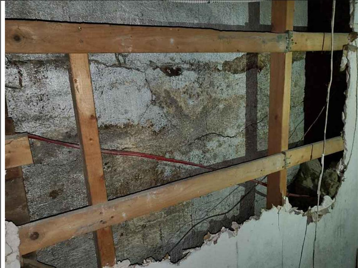
Photo 7.2 : Fissure majeure dans le mur de fondation côté Est
