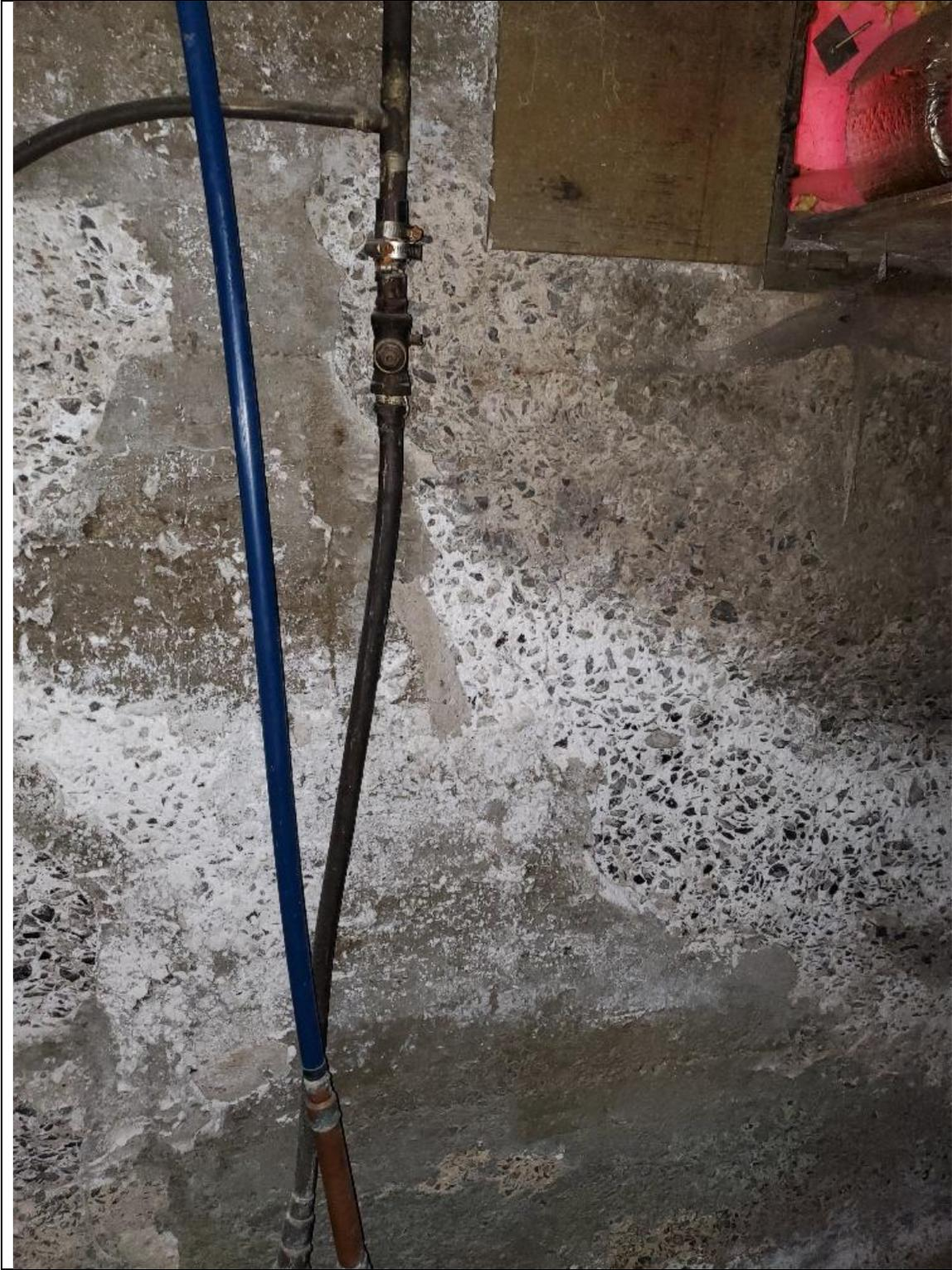
Photo 7.3 : Détachement du béton et efflorescence mur de fondation façade avant
