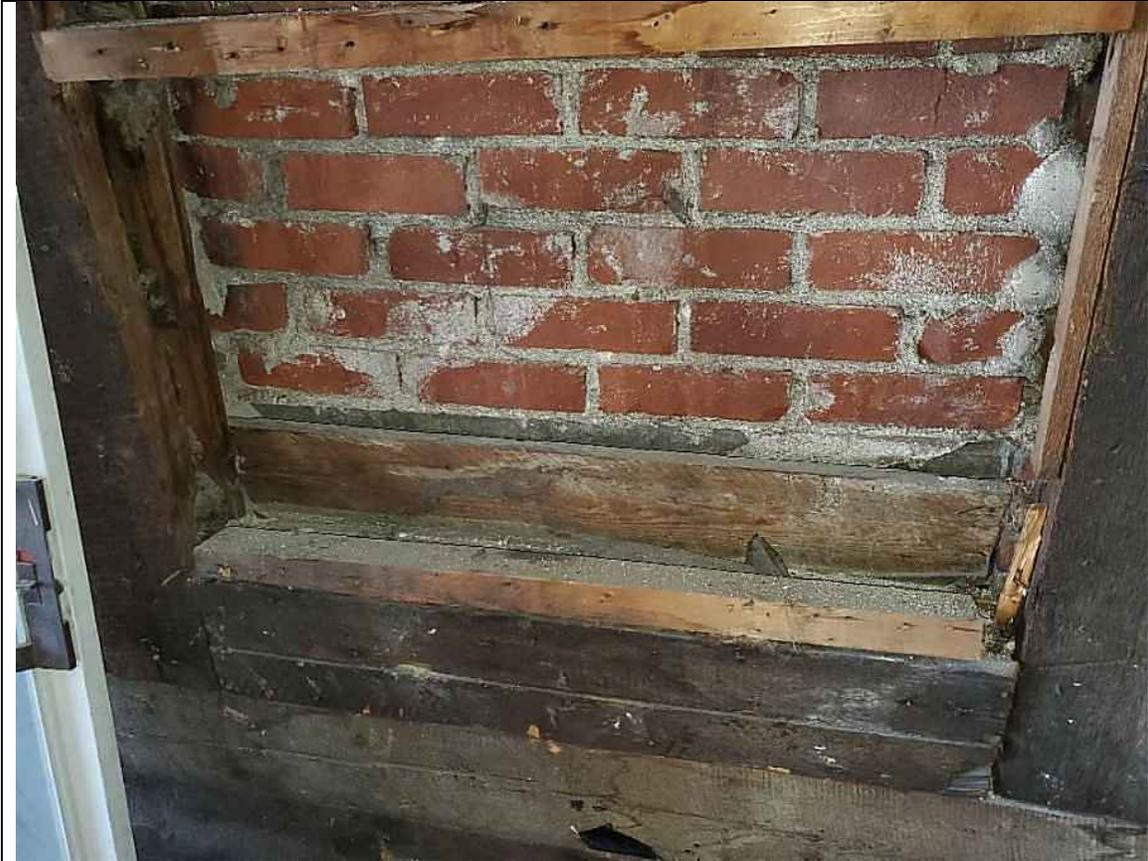
Photo 3 : Le mur de bloc coupe-feu arrête à mi-niveau du dernier étage sous une brique du parement
