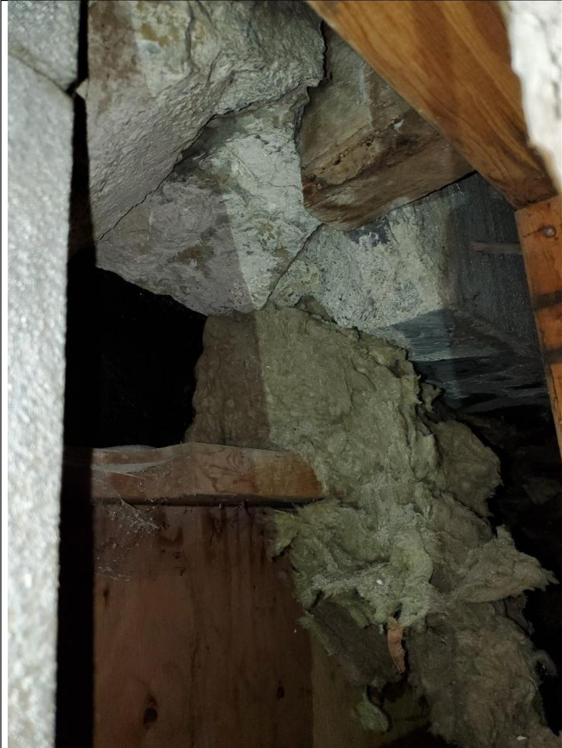
Photo 7 : Fissure / trou dans le mur de fondation côté Est
