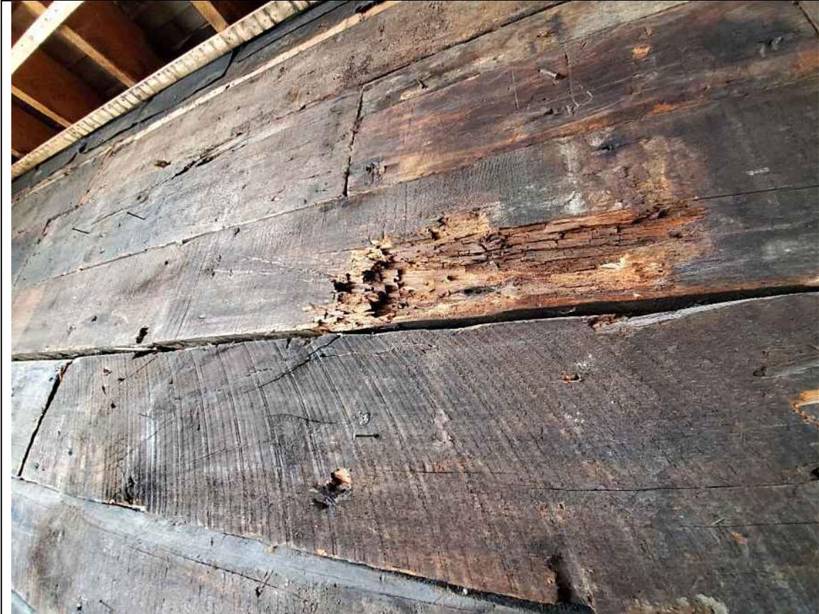
Photo 1.1 : Vide entre les planches du carré de bois et planche endommagée
