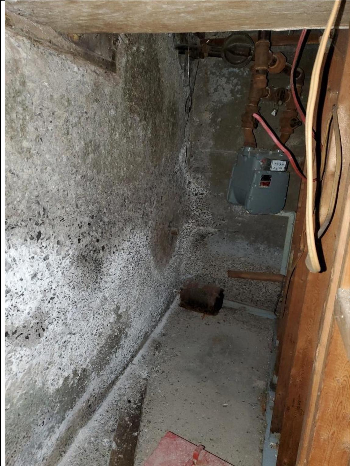
Photo 7.1 : Détachement du béton et efflorescence mur de fondation façade avant
