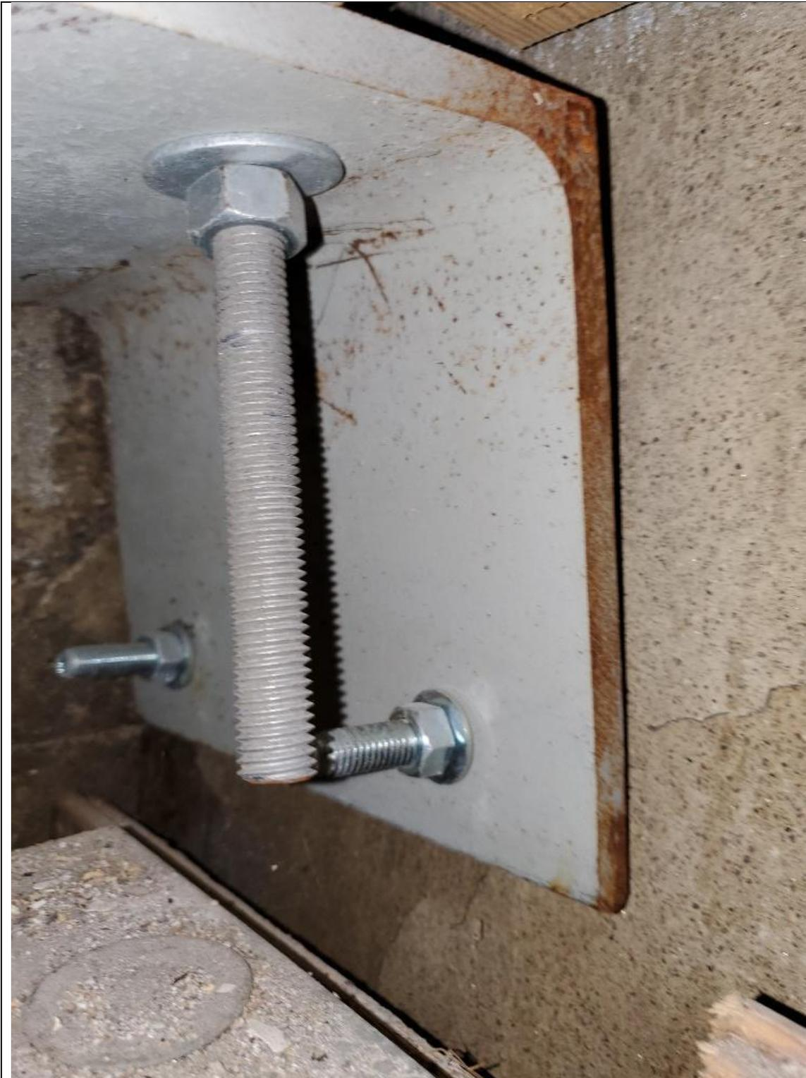
Photo 6.1 : Les cornières où les « hold-downs » sont boulonnés et ne sont pas convenablement fixés
