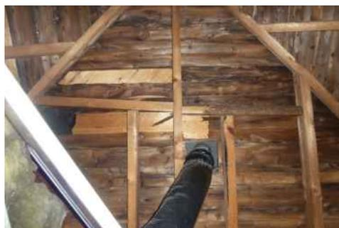
Photo 18 - Planche manquante dans la structure du toit - Entre-toit
