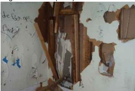
Photo 16 - Ouverture dans le gypse et montants abimés - À l'étage
