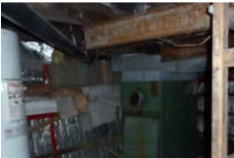
Photo 5 - Présence de rouille sur la poutre en acier du sous-sol
