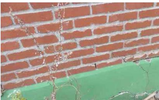
Photo 8 - Fissure en escalier dans la brique - Mur Sud
