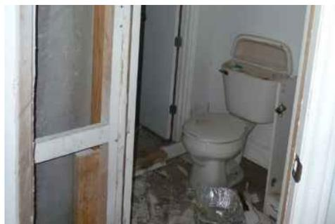
Photo 12 - Cloison démolie et appareil abimé - Salle d'eau du rez-de-chaussée
