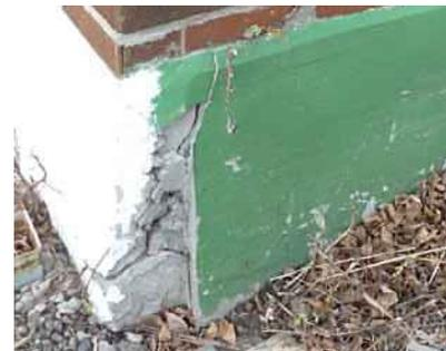
Photo 6 - Fissure dans la fondation en béton - Mur extérieur Sud
