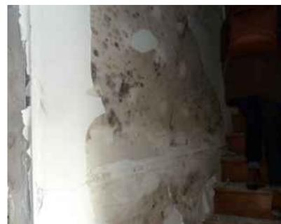
Photo 14 - Présence d'humidité sur le mur de l'escalier
