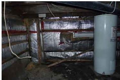
Photo 4 - Présence d'humidité sur les poutres et au plancher du sous-sol
