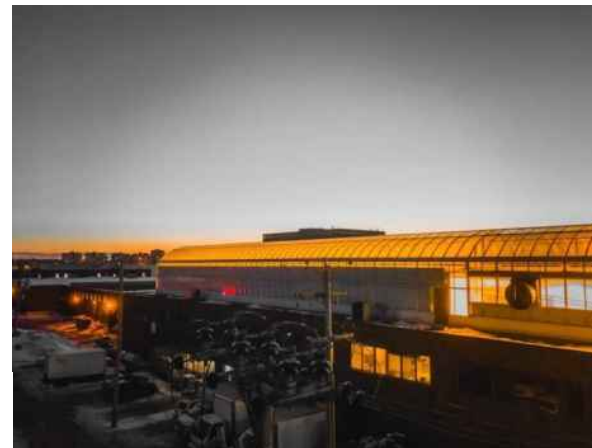
Vue du toit de la centrale agricole.
