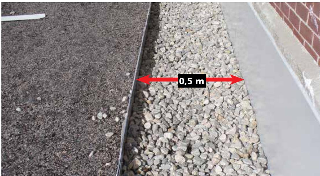
Section de toit végétalisé longeant une construction hors toit faite de matériaux de parement incombustibles (maçonnerie de brique). Dans ce cas-ci, la largeur de la zone non végétalisée peut-être réduite à 0,5 mètre.
