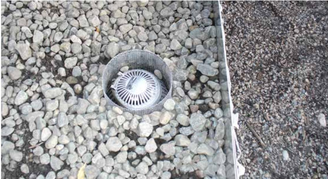
Avaloir de toit sur un des toits végétalisés de l'usine de filtration d'eau Atwater. La couche drainante se trouve sous le substrat de croissance (à droite sur la photo) et la zone libre de végétation (à gauche) constituée de gravier blanc. La bordure qui sépare les deux parties doit être installée de façon à ne pas empêcher l'écoulement des eaux sur la couche drainante. PHOTO : VILLE DE MONTRÉAL (H. CUONG NGUYEN)
