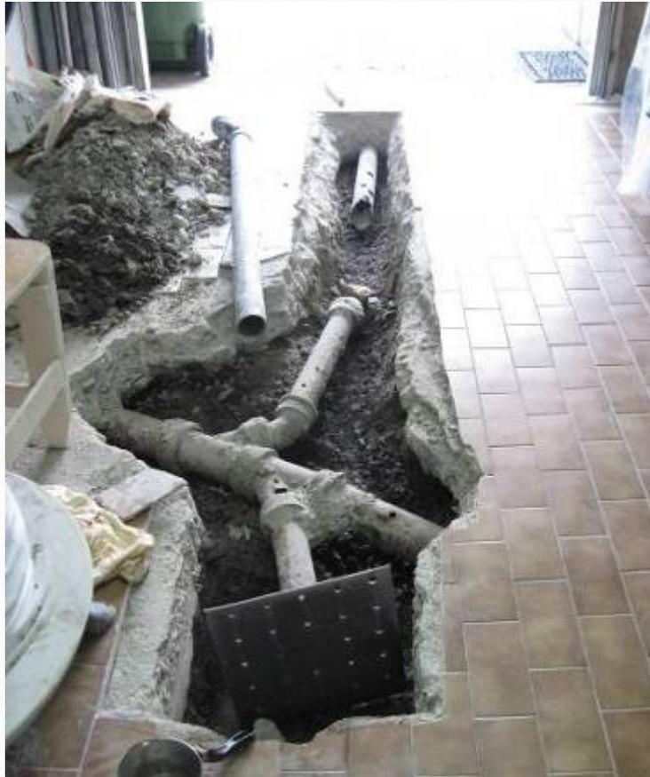
Travaux correctifs d'un citoyen de St-Léonard pour l'installation de clapets
