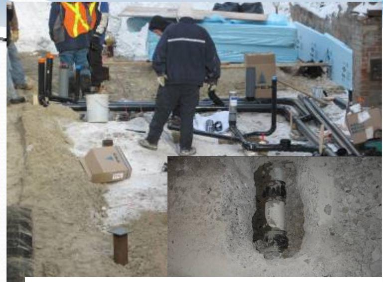
Correction – Clapet N.O. sur un condo neuf à toit plat (risque d'auto-inondation)
