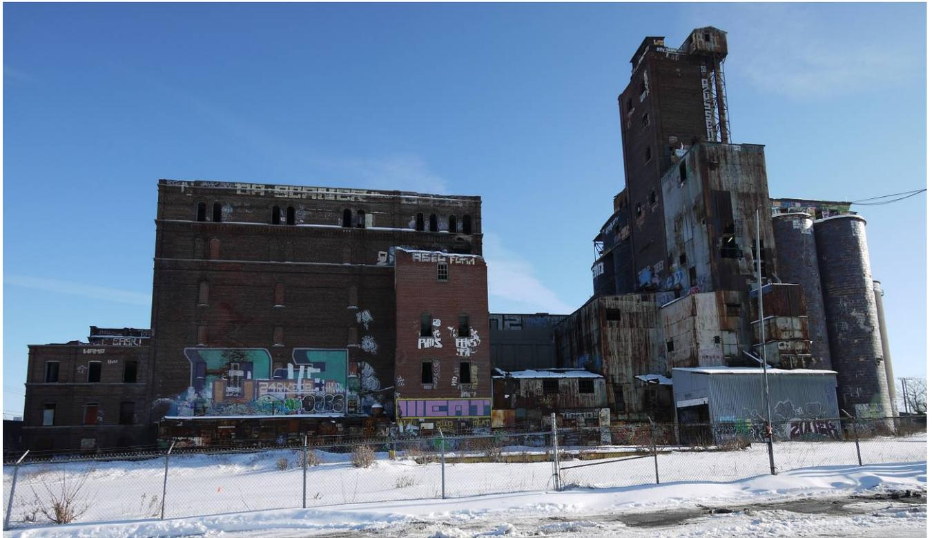
Façade ouest des installations datant de 1905 illustrant aussi les différentes sections, soit les bureaux, le séchoir, le volume dédié à l'emballage, la tour élévatrice et les silos de terra-cotta.
