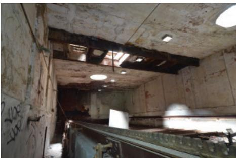
C.4.5. Le niveau supérieur est composé de poutres d'acier et de blocs de terracotta, pour une dimension totale d'environ 610 mm.
