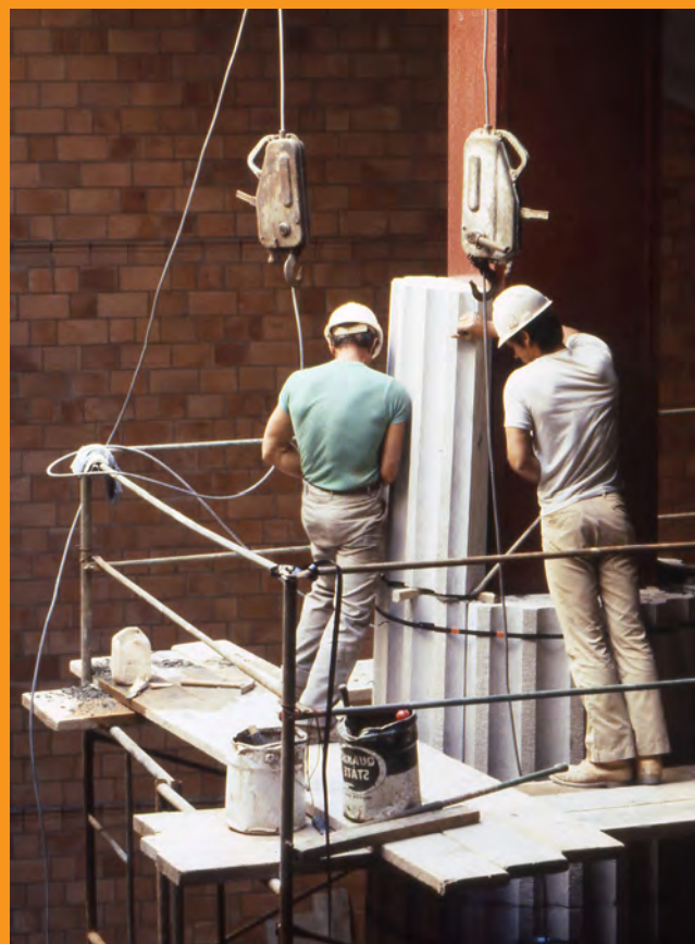
Construction de la station du Collège. Pose des blocs de calcaire qui composent l'impressionnante colonne ionique dessinée par l'architecte Gilles S. Bonetto.
