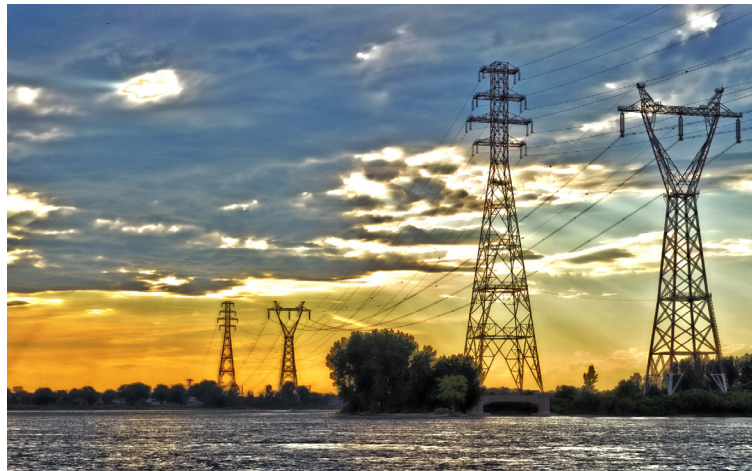
Lignes aériennes de transport d'énergie électrique
