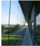
Double peau permettant la circulation d'air intérieure
