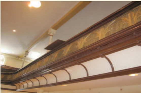
Balustrade du Dawson Hall en 2015 Photo : Ville de Montréal
