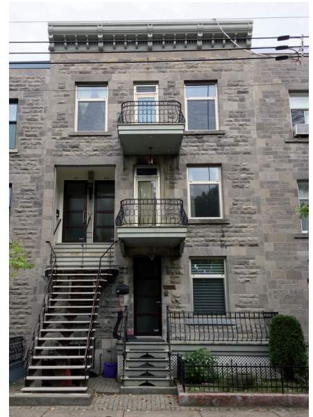
Plex victorien - hauteur d'environ 12 mètres
