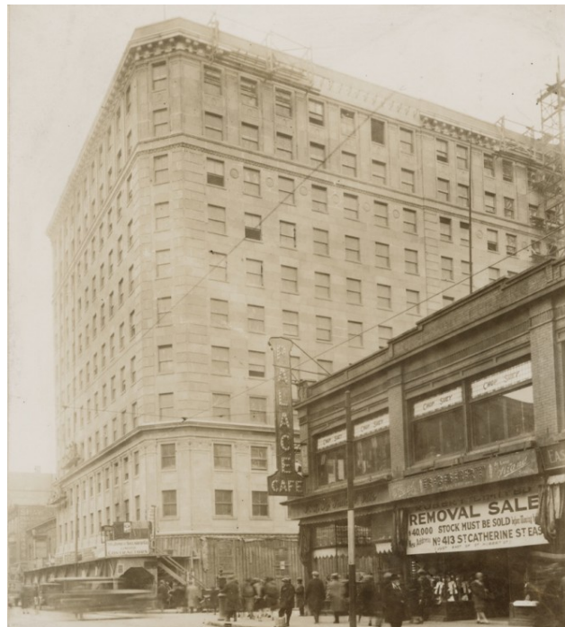
Vue historique du secteur à l'intersection de l'avenue McGill College et de la rue Sainte-Catherine Ouest, illustrant le Confederation Building en cours de construction vers 1927-1928 . Source : BAnQ, fonds La Presse, cote P833,S3,D866. Reproduit de l'étude documentaire de Brodeur Consultants (2026).
