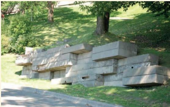
Mur de soutènement à caissons.
