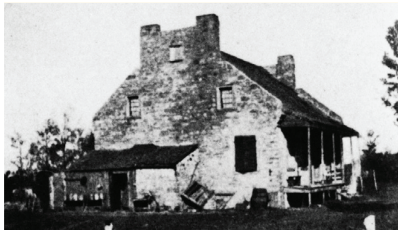
Maison Thomas-Brunet avant la transformation en 1920. Source : Répertoire d'architecture traditionnelle sur le territoire de la Communauté urbaine de Montréal, p. 255.
