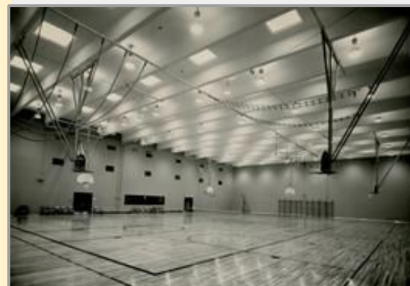
Gymnase (pavillon E) construit en 1966 photo vers 1966, Source : Studio Lausanne Co., 4.1.6.10 CON/GYP/2.
