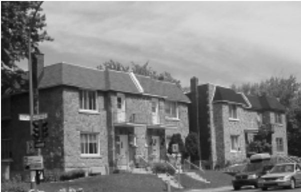
17.1.13 Résidences jumelées, avenue Victoria
