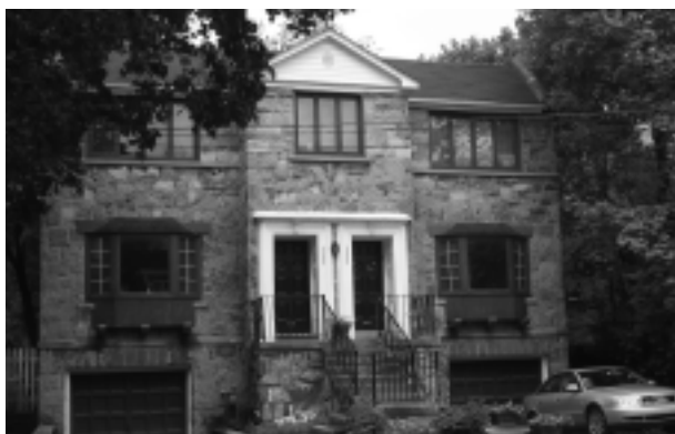
17.1.14 Résidences jumelées, avenue Grosvenor
