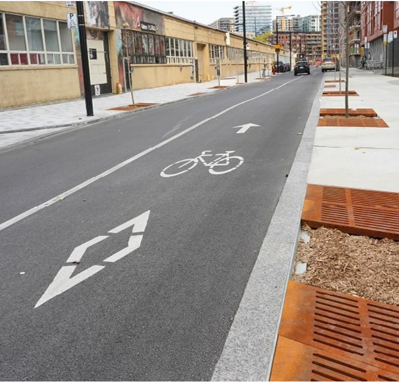
Réaménagement de la rue Ottawa, entre les rues Guy et du Séminaire © Ville de Montréal
