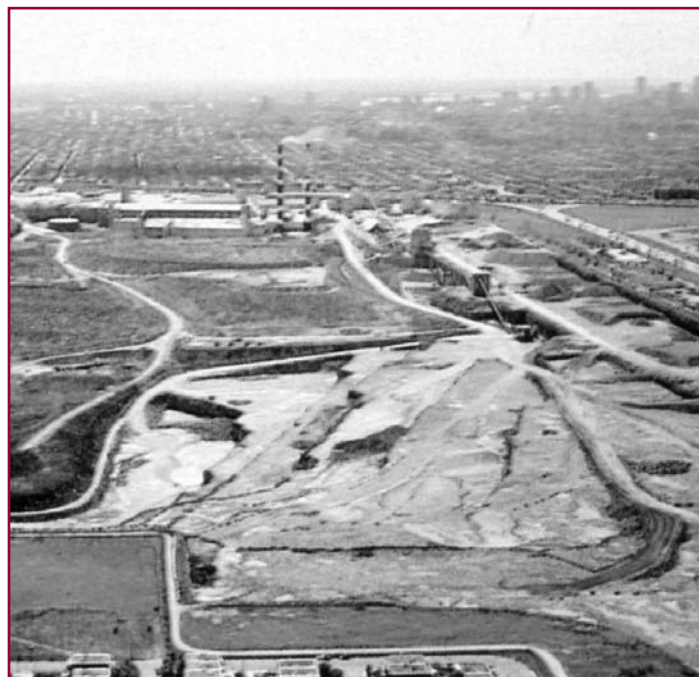
Le site Miron avant la démolition de la cimenterie. Ville de Montréal.
