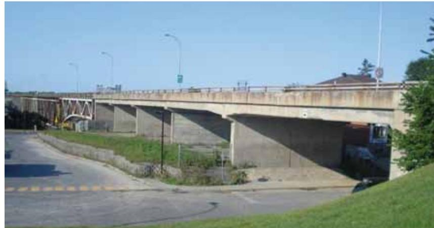
Le viaduc ouest sera démolé et remplacé par une nouvelle structure à murs pleins en béton texturé, légèrement plus large, puisque le nouveau tablier du pont Mercier sera doté d'une piste cyclable et piétonne séparée de la chaussée. Quant au viaduc est, qui repose solidement sur ses étais, sa démolition ne se fera que dans deux ans, lors du remplacement du tablier du pont Mercier en direction de Montréal.
