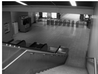
Accès au quai à la station de métro Rosemont Source : V. Colas.
