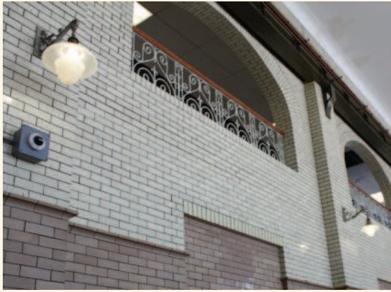
La salle des pompes de la station de pompage centrale
