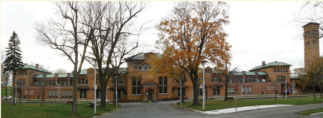
La station de pompage centrale et à droite la tour d'amorçage des pompes (Source: Lafontaine & Soucy, architectes, 2014)
