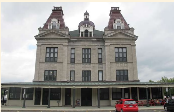
Façade latérale (Source : LuceLafontaine Architectes, 2019)
