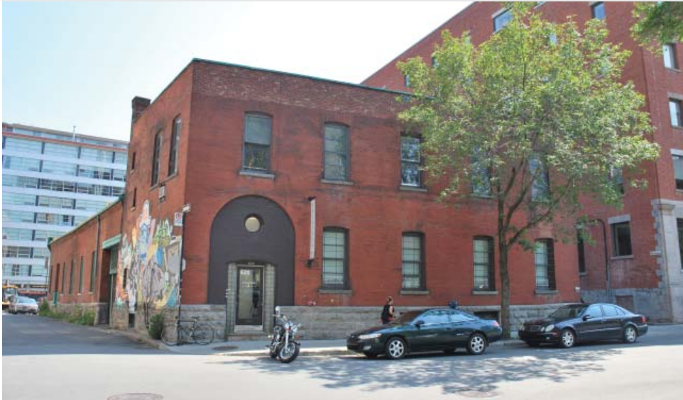
Immeuble John Lysaght Limited (Source : Ville de Montréal, août 2013)
