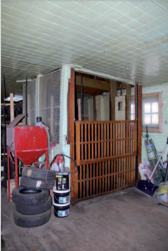
Monte-charge servant l'entreposage des marchandises (Ville de Montréal, janvier 2012)
