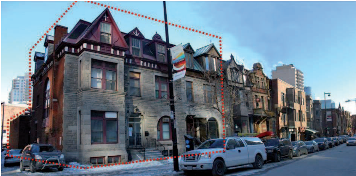
Ensemble bordant le côté est de la rue Bishop. Le site visé est liséré d'une ligne pointillée rouge. (Source : Ville de Montréal (VdM), janvier 2013)
