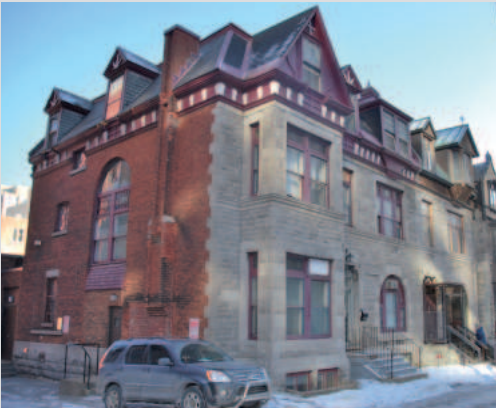
Façades latérale et avant des bâtiments situés aux 2085 et 2075, rue Bishop. (Source : VdM, 18 janvier 2013)
