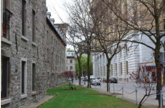
La façade de l'aile de la communauté et son dégagement sur la rue Normand Photo : Ville de Montréal, 2013
