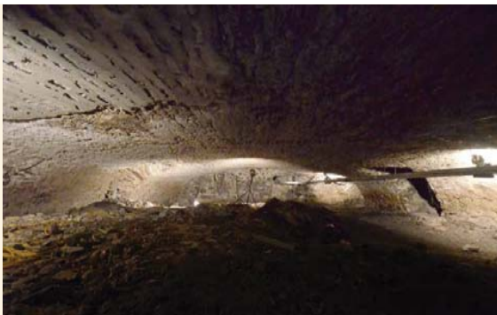
Cave voûtée de l'aile de la communauté Photo : Beaupré Michaud et Associés, Architectes, 2013
