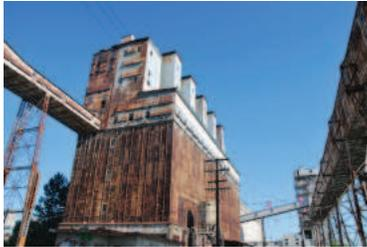
Achevé en 1906, l'**élévateur B** conçu par John S. Metcalf est composé de silos carrés en plaques d'acier rivetées. Le rez-de-chaussée est destiné à la réception et expédition des grains avec les rails qui entrent dans l'édifice, les trois derniers étages sont dédiés au tri, au pesage et à la distribution des grains dans les différents silos. Les céréales sont acheminées en haut grâce à des godets fixés sur une courroie sans fin verticale.
