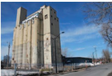
Le silo Rozon est bâti en béton armé 1922 par l'ingénieur N. Bowman pour la Dominion Lindseed Oil. Il est construit sur le coursier n° 2 comprenant bassin de récupération, trois turbines et canal d'évacuation et faisait partie d'un complexe de quatre édifices.
