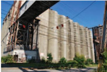
L'**annexe** terminée en 1914, également conçue par Metcalf, est en béton armé et constituée de 28 silos cylindriques. Elle est reliée à l'élévateur principal par un convoyeur aérien. Trente deux nouveaux cylindres sont ajoutés entre 1924 et 1928 et une sous-station électrique est construite entre l'élévateur B et l'annexe.
