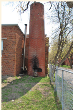
Cheminée. Source: Ville de Montréal 2016
