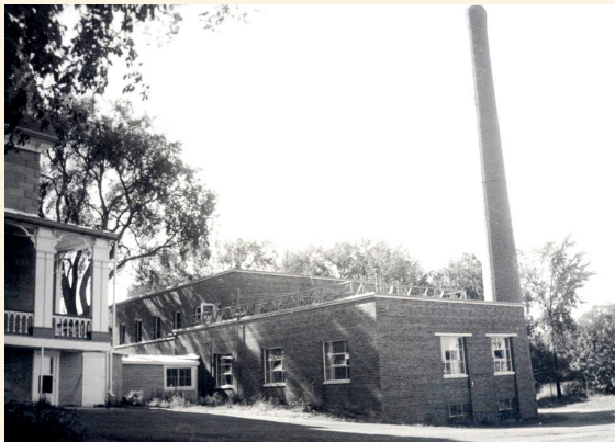
La buanderie-chaufferie et sa cheminée. Fonds d'archives des Soeurs de Miséricorde.
