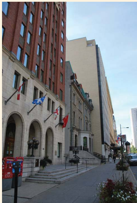
Front bâti sur la rue Sherbrooke (source : Ville de Montréal, septembre 2014)
