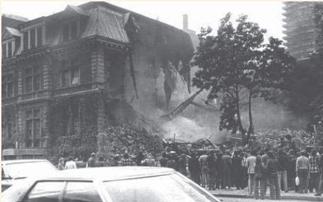
Démolition de la maison Van Horne (Source : La Presse, 10 septembre 1973s)
