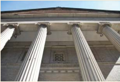
Colonnade de la façade de l'église Emmanuel Congregational (source : Ville de Montréal, sept. 2014)
