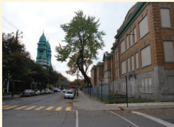
L'école Baril et l'église Très-Saint-Rédempteur vues depuis la rue Adam (Ville de Montréal, octobre 2013)
