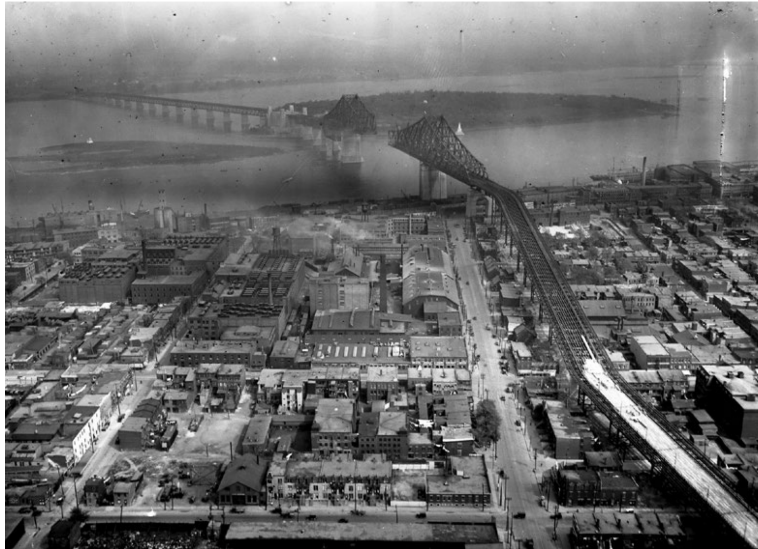
Vue sur la construction du pont Jacques-Cartier, en 1927
