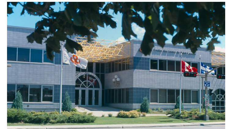
Fig. 124. Centre des loisirs de Saint-Laurent implanté sur la rue Grenet au sud de l'aire TOD (Source: Ville de Montréal)
