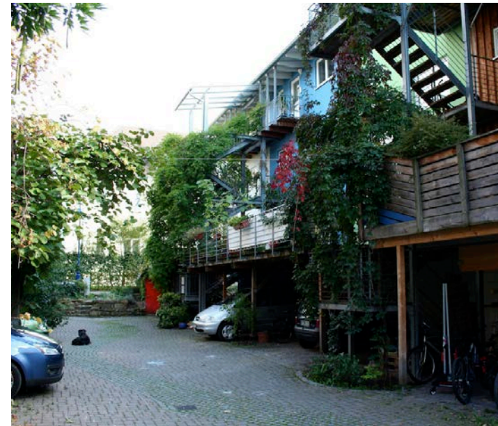
Fig. 195. Stationnements dissimulés sous les terrasses, Fribourg-en-Brisgau, Allemagne (Source: Vivre en Ville)
