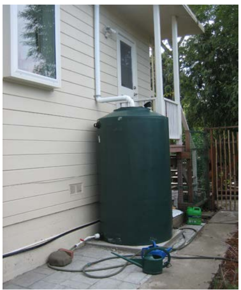
Fig. 174. Baril d'eau de pluie sur le domaine privé (Source: Grey Water Action)
