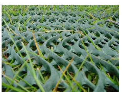
Fig. 176. Matériaux de revêtement de sol (béton poreux, pavé alvéolé, mailles de plastique et interbloc) favorisant l'infiltration d'eau (Source: Divers)
