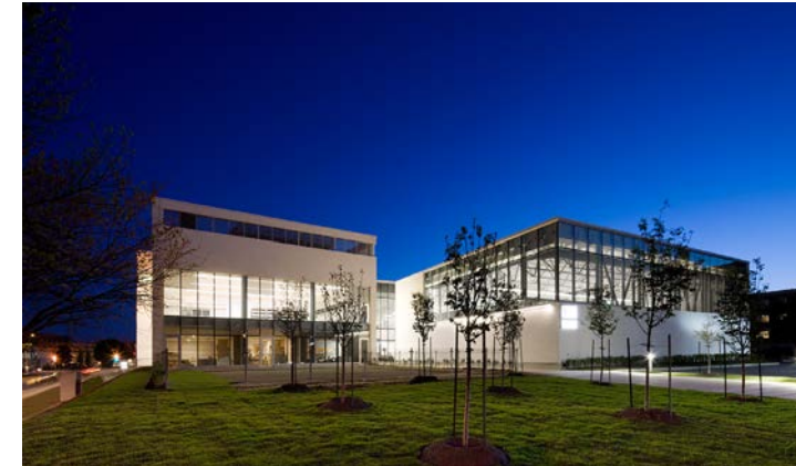
Fig. 120. YMCA Cartierville bordant la rue Grenet (Source: Daoust Lestage)
