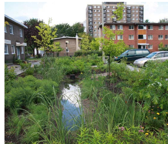
Fig. 199. Noue paysagère en bordure d'un stationnement de surface, Habitations Jeanne-Mance, Montréal (Source: Médiaterre)
