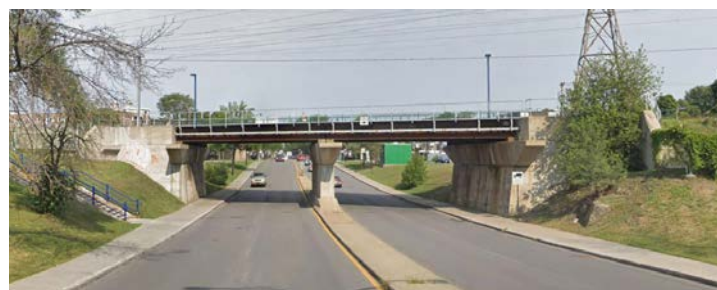
Fig. 19. Rue Grenet (Source: Streetview, Août 2018)
