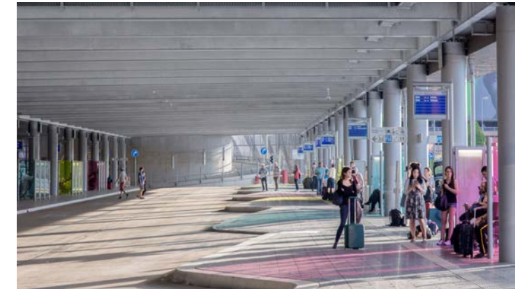
Fig. 188. Aménagements intérieurs conviviaux et sécuritaires du terminus d'autobus, Aéroport de Stuttgart, Allemagne (Source: Wulf Architekten)
