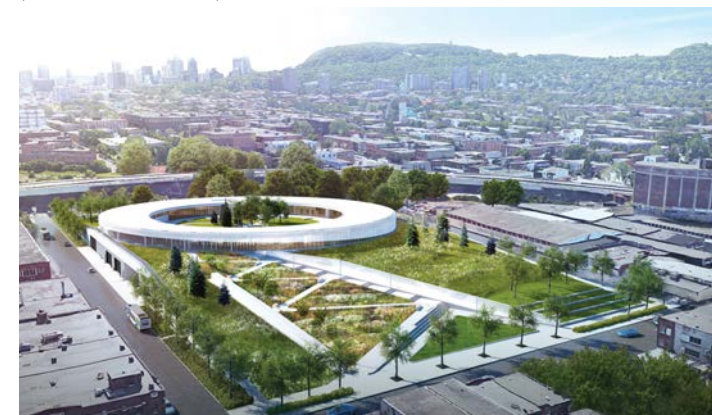
Fig. 191. Centre de transport Bellechasse de la STM, partiellement aménagé en souterrain (Source: Canadian Architects)
