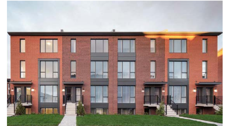
Fig. 147. Plex de 3 étages, Bois-Franc, Montréal (Source: Ecohabitation)
