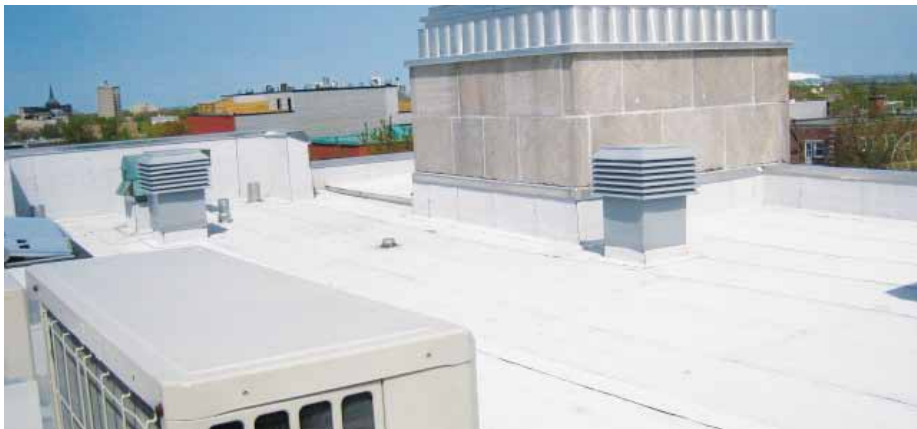
L'aménagement de toits blancs, tel que cela a été fait à la bibliothèque Rosemont, est un outil efficace de lutte contre les îlots de chaleur.
