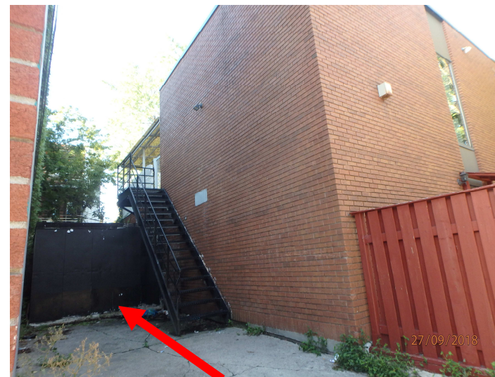
Dépendance qui sera démolie – congélateur de l'ancien restaurant
