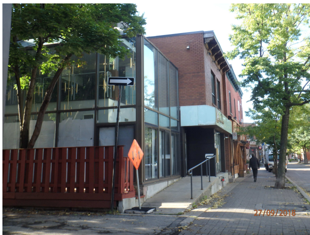
La rampe d'accès
