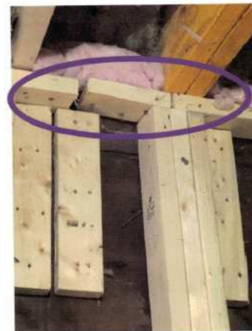
Photo no. 11 - Mur latéral côté stationnement
