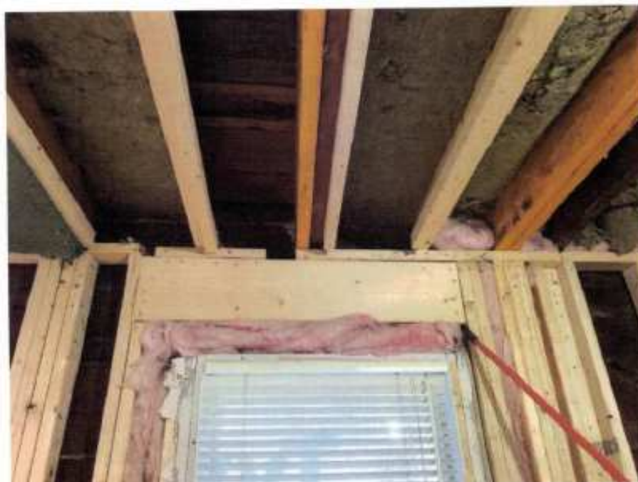
Photo no. 12 - Mur latéral côté stationnement
