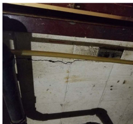
Photo 5 : Mur de blocs au sous-sol endommagé
