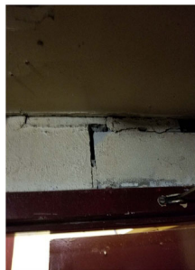
Photo 5 : Mur de blocs au sous-sol endommagé
