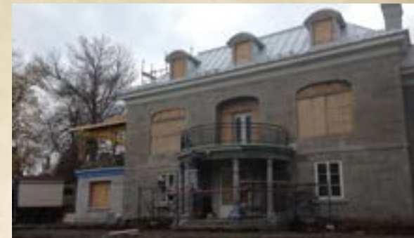
La maison durant des travaux. The house during the restoration.
