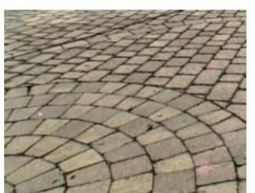
Fig. 176. Matériaux de revêtement de sol (béton poreux, pavé alvéolé, mailles de plastique et interbloc) favorisant l'infiltration d'eau
