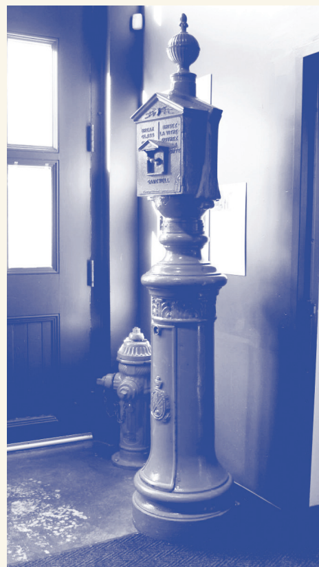
Borne d'alarme incendie – Centre d'histoire de Montréal
