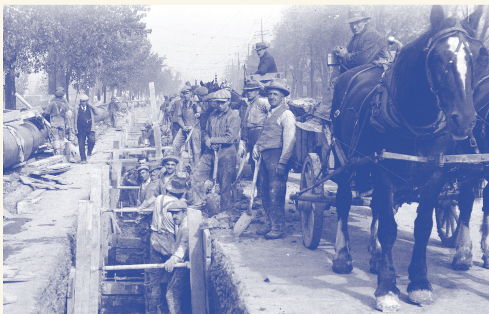
Travaux de canalisation à Montréal. 26 octobre 1931 - Archives de la Ville de Montréal, VM117-Y-1P4476
