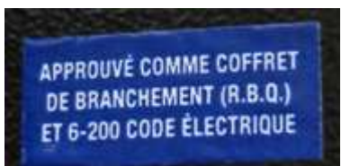
Figure 10: Étiquette de certification du coffret de branchement
