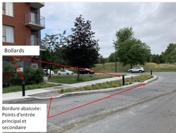
Figure 12 – Vue générale d’une avancée de trottoir drainante – Présence de bollards, d’un point d’entrée principal et secondaire
