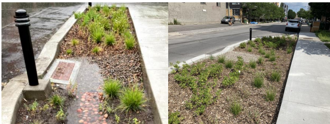
Figure 11 – Exemple de caniveau de sédimentation (à gauche) et d'embrochement (à droite)
