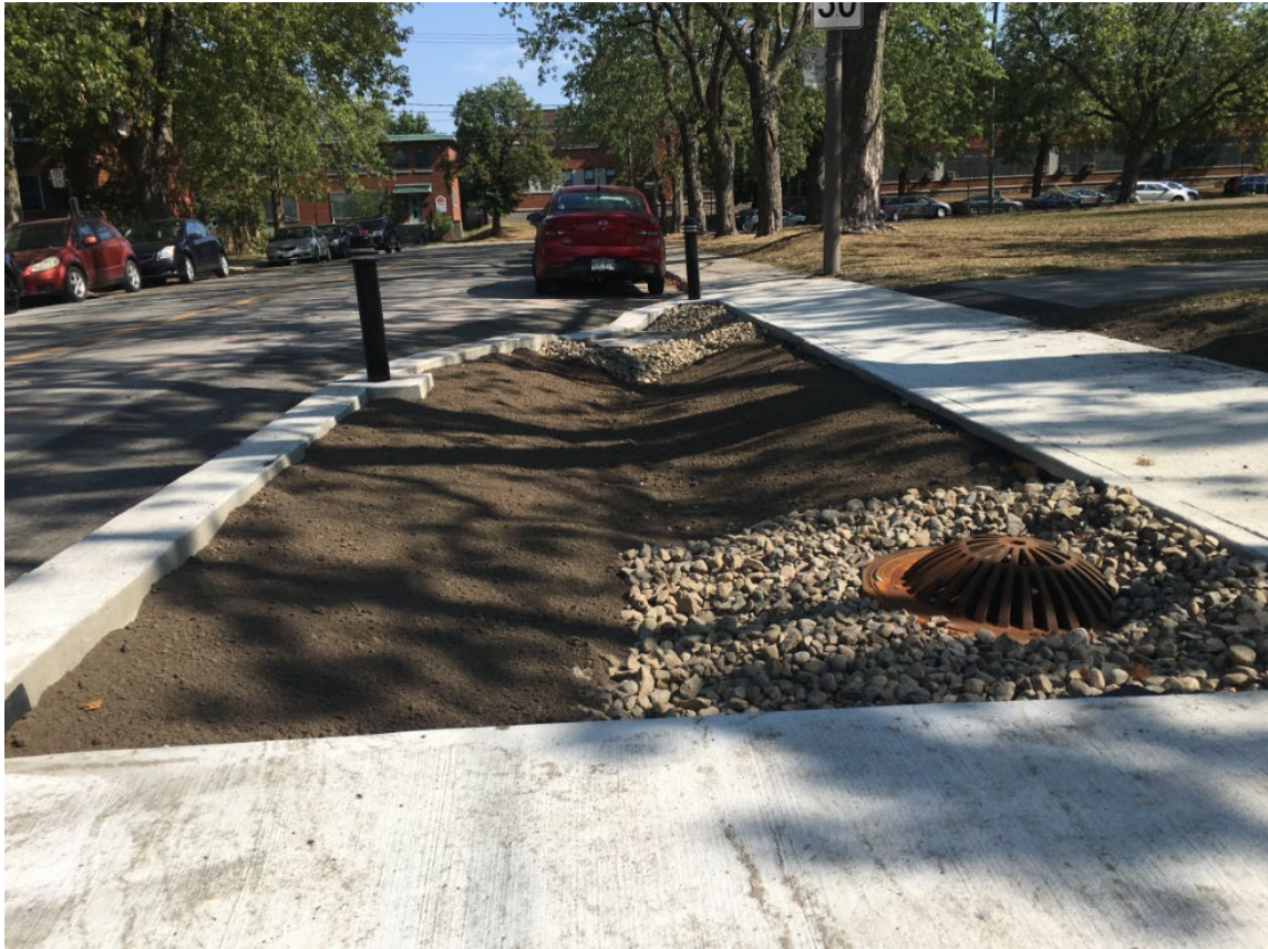
Figure 15 – Puisard de trop plein avec enrochement pour limiter le dénivelé entre le trottoir et le niveau du fond
