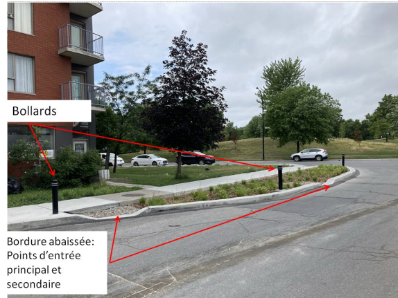
Figure 12 – Vue générale d'une avancée de trottoir drainante Présence de bollards, d'un point d'entrée principal et secondaire
