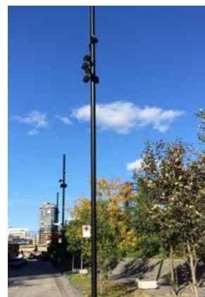
PROJECTEURS D'ÉCLAIRAGE SUR MÂT À LA PROMENADE SMITH
