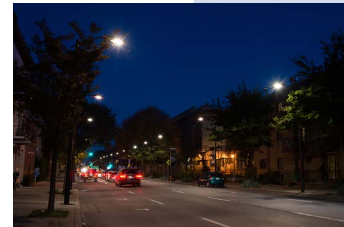
RUE PAPINEAU – NOUVEL ÉCLAIRAGE OFFRANT UNE EXCELLENTE UNIFORMITÉ SUR LA CHAUSSÉE
