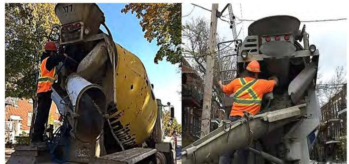
L'ajout de l'eau modifie le ratio eau/ciment du mélange et peut engendrer une perte significative de la résistance du béton et de la capacité à subir des cycles de gel et dégel.
