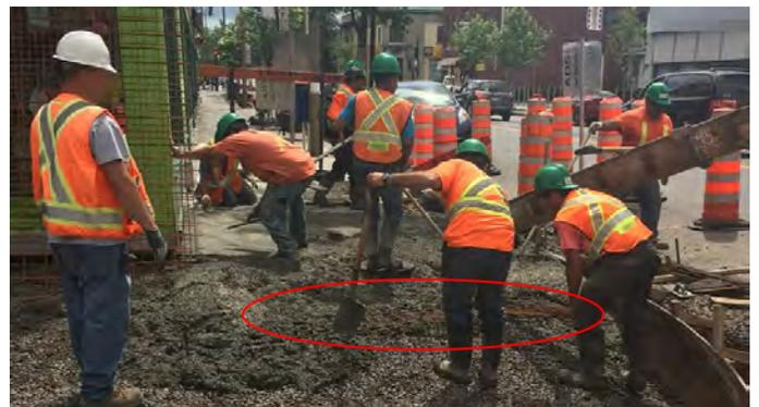
Le treillis métallique non supporté ne vient pas jouer son rôle d'armature dans le béton s'il se retrouve au fond. Le béton est un matériau possédant de très bonnes propriétés en compression, mais pas en tension. Les devis de la Ville demandent l'ajout de treillis métallique à certains endroits précis où les trottoirs sont plus sollicités en tension. Des dislocations du trottoir peuvent apparaître en l'absence d'armature adéquate.
