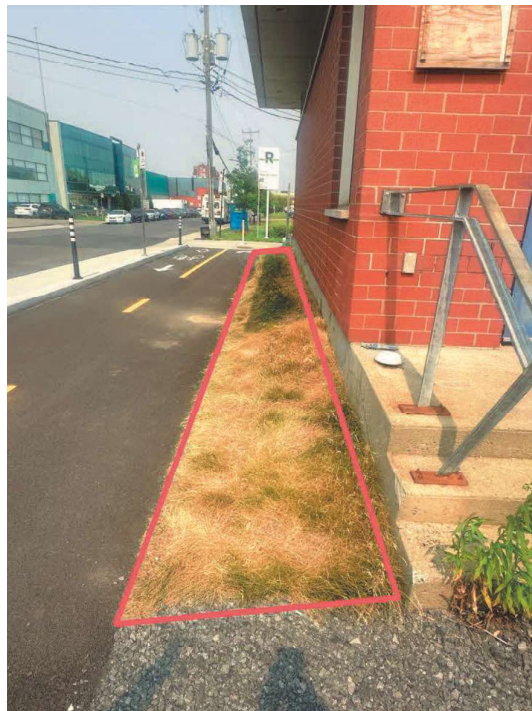
Prêt d'immeuble 3587 – 135, rue Stinson, Ville St-Laurent
